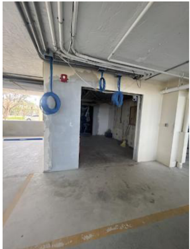
DATA CABLE - CONDUIT WORK
