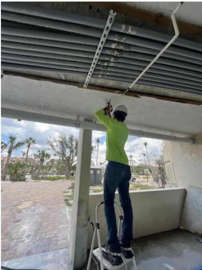
GARAGE CONDUIT RECONSTRUCTION
