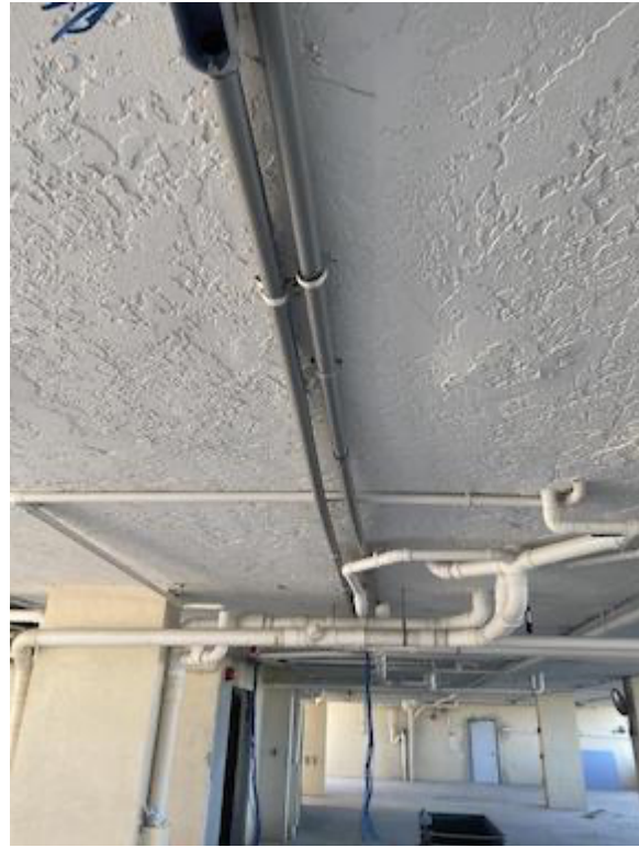
GARAGE CONDUIT CONSTRUCTION
